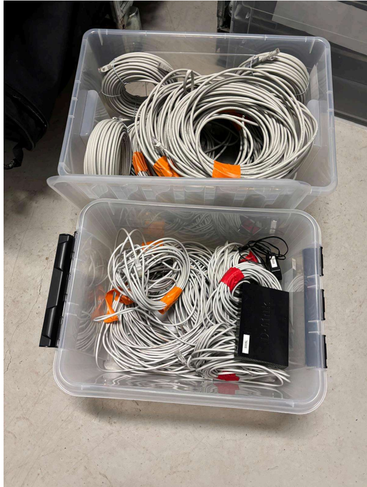
Kuva 9. Ethernet-johdot ja kytkin
